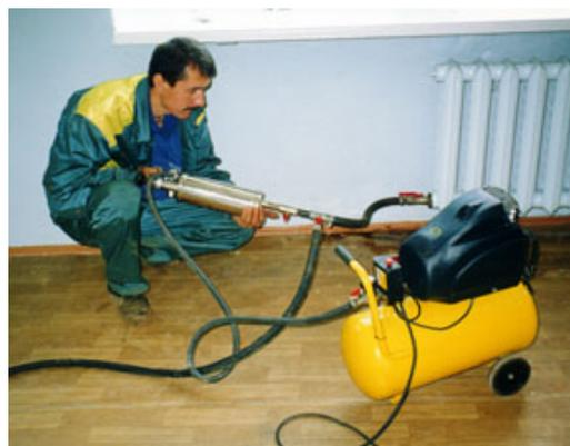
Использование пневмопистолета в паре с аппаратом Крот-мини, который обеспечивает предварительное разрушение сверхпрочных засоров, повышает общую эффективность и быстродействие очистных работ.
