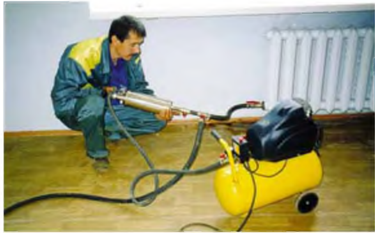
ОЧИСТКА РАДИАТОРА ОТОПЛЕНИЯ
