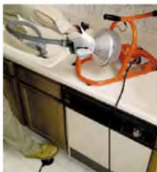
ПРОЧИСТКА СЛИВА РАКОВИНЫ
